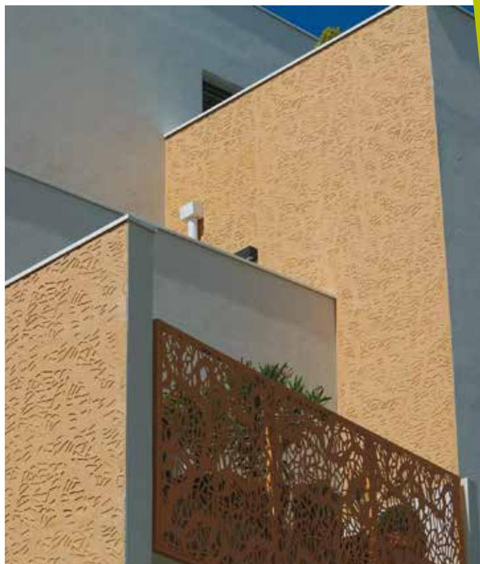
**Autre caractéristique capitale, la tenue au feu d'un système d'ITE, plus performante avec un enduit hydraulique et d'autant plus élevée lorsque ledit système est associé à un isolant en laine de roche.**
