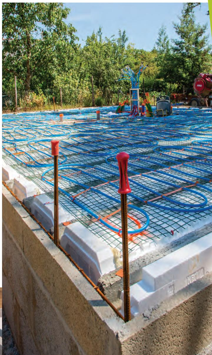
La résistance thermique de l'ensemble dépendra essentiellement de la nature, de l'épaisseur et de la forme des isolants. Elle peut varier de 2,5 à 6 m<sup>2</sup> K/W et atteindre avec les rupteurs 9 m<sup>2</sup> K/W.
