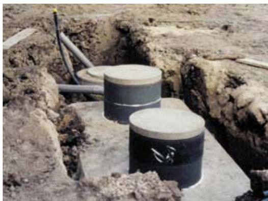
pour l'ensemble des eaux ménagères. Il est implanté obligatoirement à moins de 2 mètres de la maison pour éviter un colmatage de la canalisation par les graisses.
