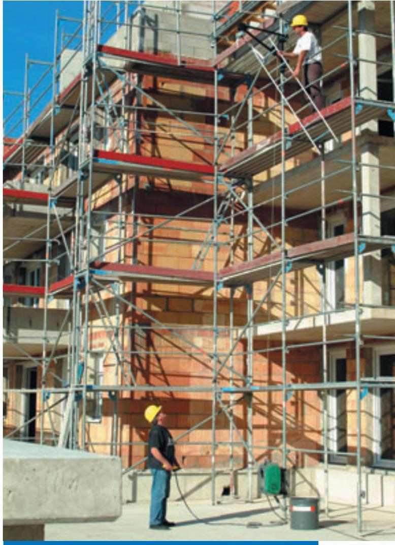
Les échafaudages sont montés de telle façon que leurs composants ne puissent pas se déplacer lors de leur utilisation. Aucun vide de plus de vingt centimètres ne doit exister entre le bord des planchers et l'ouvrage ou l'équipement contre lequel l'échafaudage est établi.
