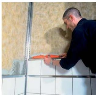
*La sous-couche s'applique sur le mur (et/ou le plancher) préalablement encollé. Elle est marouflée soigneusement pour chasser les bulles d'air. Les lés se chevauchent sur 5 cm. Des profilés disponibles en différentes finitions et épaisseurs/hauteurs sont posés pour réaliser le raccordement entre le carrelage mur-sol et apporter une note décorative. Ils ne sont pas indispensables, mais ils confortent l'étanchéité et apportent une excellente finition.*
