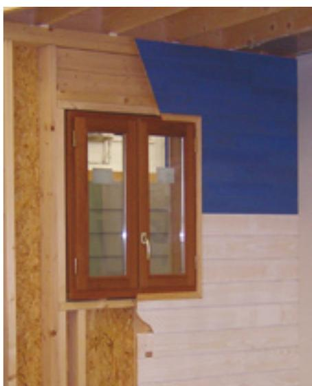
L'ossature «bois-panneaux» est une évolution de la technique du colombage : la structure de la maison est également constituée d'un ensemble de montants et de traverses en bois mais de plus faibles sections, peu espacés, qui forment un cadre sur lequel on vient fixer des panneaux de contreplaqué ou d'OSB qui assurent à l'ensemble une exceptionnelle rigidité, le contreventement de la structure. On dispose, entre les montants et les
