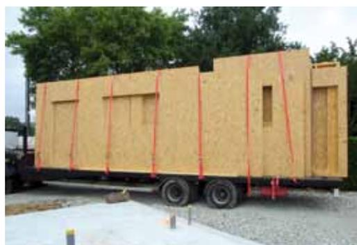
**L'industrialisation de la technique avec la standardisation des sections des bois, à l'instar des blocs de béton et de briques, simplifie les approvisionnements et réduit le temps d'assemblage.** Des pans de murs entiers (jusqu'à 12 m de longueur et 3 m de haut) sont ainsi construits. Il suffit de les redresser, soit manuellement, soit à l'aide de palans. Les éléments de l'ossature des parois sont assemblés en atelier (panneaux préfabriqués) ou sur le chantier (système pré-cut) :
