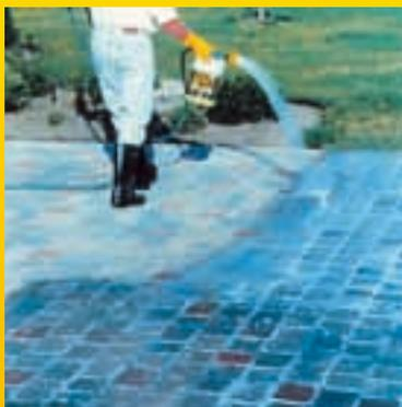
Deux à trois mois après une pose scellée ou collée, des efflorescences de ciment apparaissent souvent et doivent être retirées avec un nettoyeur ou décapant, à base d'acides organiques et parfois d'acide chlorhydrique, qui s'applique, pur ou dilué selon les produits, sur le revêtement.
