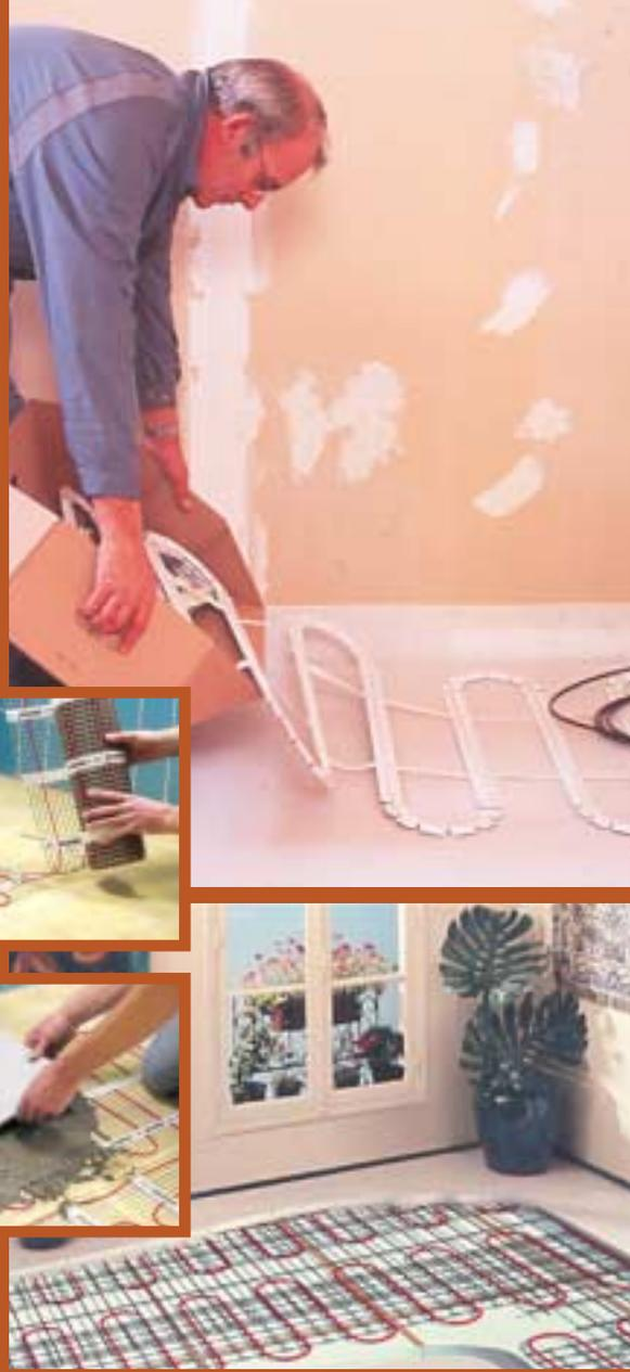
chauffage électrique. Un câble chauffant, noyé dans une dalle de béton de 8 cm d'épaisseur minimum, est alimenté pendant les "Heures Creuses" de la tarification d'EDF. Il réchauffe la dalle qui restitue dans la journée la chaleur emmagasinée. Un appoint est fourni par des convecteurs, des panneaux radiants... qui apportent un complément de chaleur si nécessaire en cas de variations brutales de la température extérieure.
