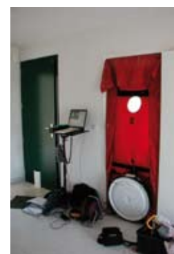
Test de perméabilité à l'air "Blower Door"
