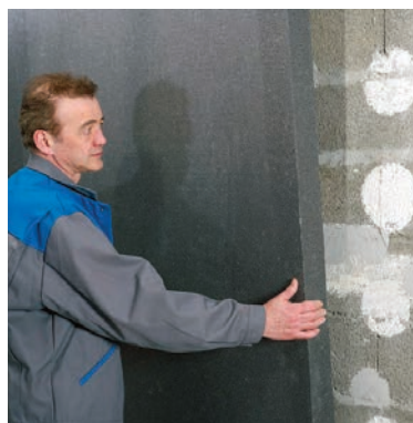
Autre solution d'ITI (Isolation Thermique par l'Intérieur), des panneaux de polystyrène à coller. Ici un PSE graphité qui contient du graphite de granit réputé performant. Il est ensuite recouvert de plâtre.
