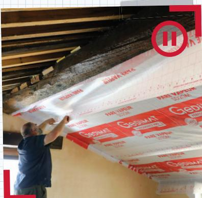
Le pare-vapeur est posé à l'horizontale, en lés entiers d'un mur à l'autre, de bas en haut. Pour fixer le lés suivant, il faut coller une nouvelle bande adhésive double face sur la fourrure inférieure.
