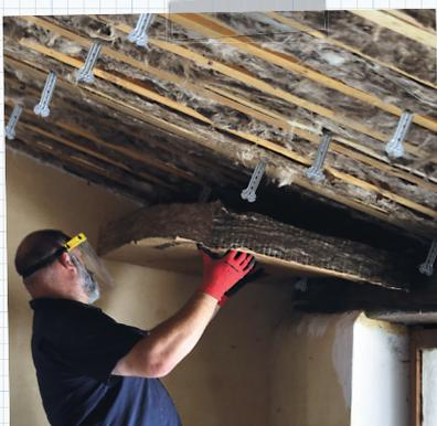
**La deuxième épaisseur, plus importante, est posée à l'horizontale.** Cela permet de croiser les deux couches et donc de réduire la présence éventuelle de ponts thermiques. **L'isolant est juste coincé** entre les suspentes.
