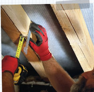
Les suspentes de l'ossature des plaques de plâtre sont les couteaux suisses de l'isolation. **D'abord, elles se règlent en fonction de l'épaisseur de la deuxième couche**, placée devant les chevrons.
