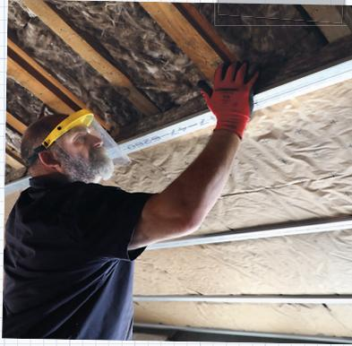
**Le maintien de l'isolant est complété par la mise en place immédiate des fourrures,** emboîtées sur la tête des suspentes. Il faut bien veiller à serrer les panneaux isolants les uns contre les autres.
