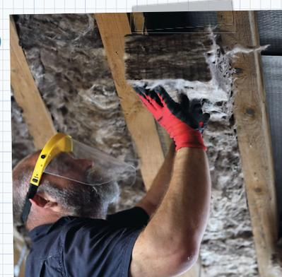
**Les panneaux nécessaires à la première couche isolante sont recoupés en largeur égale** à celle mesurée entre les chevrons, augmentée de 1 cm. Grâce à cela, ils sont simplement coincés dans l'espace disponible.
