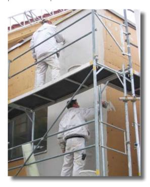
Les performances d'un mur-manteau s'expriment lorsque la construction comporte un étage minimum, car elles suppriment les ponts thermiques au niveau des planchers intermédiaires. Sur une maison de plain-pied, les mesures montrent que l'ITE et l'isolation intérieure font jeu égal.
