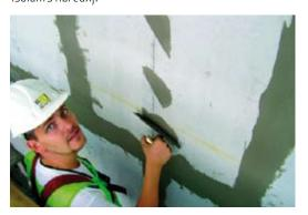
L'ensemble est armé avec un treillis métallique ou en fibre de verre noyé dans un sous-enduit. Un enduit de finition mince, un Revêtement Plastique Épais [RPE] appliqué à la taloche ou au rouleau, assure la protection et la finition ribbée, talochée, roulée...
