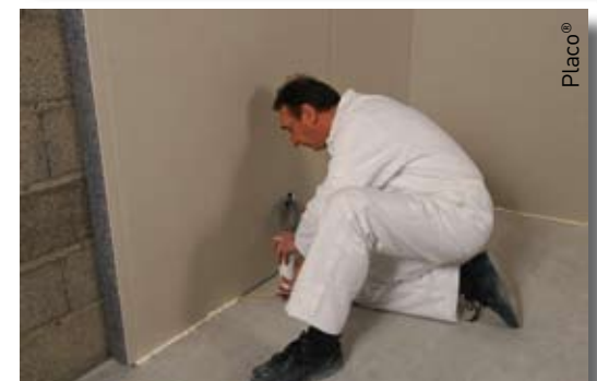
Pour améliorer l'étanchéité à l'air du mur, la pose des doublages nécessite aujourd'hui celle d'un boudin de mortier-colle en partie haute, et d'un calfeutrage à la mousse polyuréthane en partie basse.
