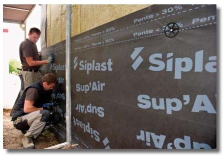
Un frein-vapeur n'est pas totalement étanche à la vapeur d'eau ; il est "respirant". Il possède une résistance à la vapeur d'eau soigneusement calculée pour éviter la formation de condensation et de ponts thermiques (Sd entre 2 et 5 m). Un frein-vapeur est adapté aux isolants fibreux peu sensibles à l'humidité, donc aux laines minérales, mais pas aux laines végétales (chanvre, bois) ou animales (mouton), pour lesquelles il faut utiliser un pare-vapeur.
