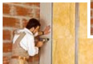
de la structure. Avec une "72/48", l'indice  $R_w$  est de 42 dB avec laine minérale, et 34 dB sans. Des performances optimales sont possibles en vissant soit deux plaques de plâtre de chaque côté, soit deux d'un côté et trois de l'autre.
