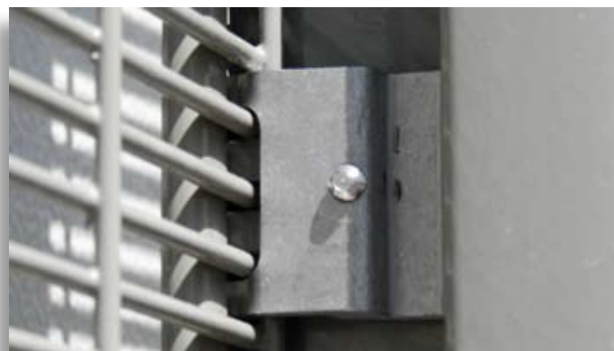
Bloqueur de clips sécurité avec panneau et poteau Sécurité
