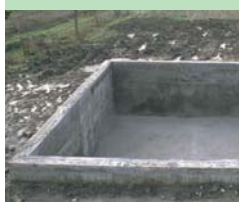
Ouvrage en milieu agricole
