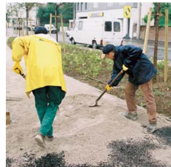
Etape 3 : Épandage et réglage du Stabex
