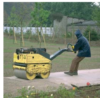
Etape 4 : Compactage en 3 à 4 passes
