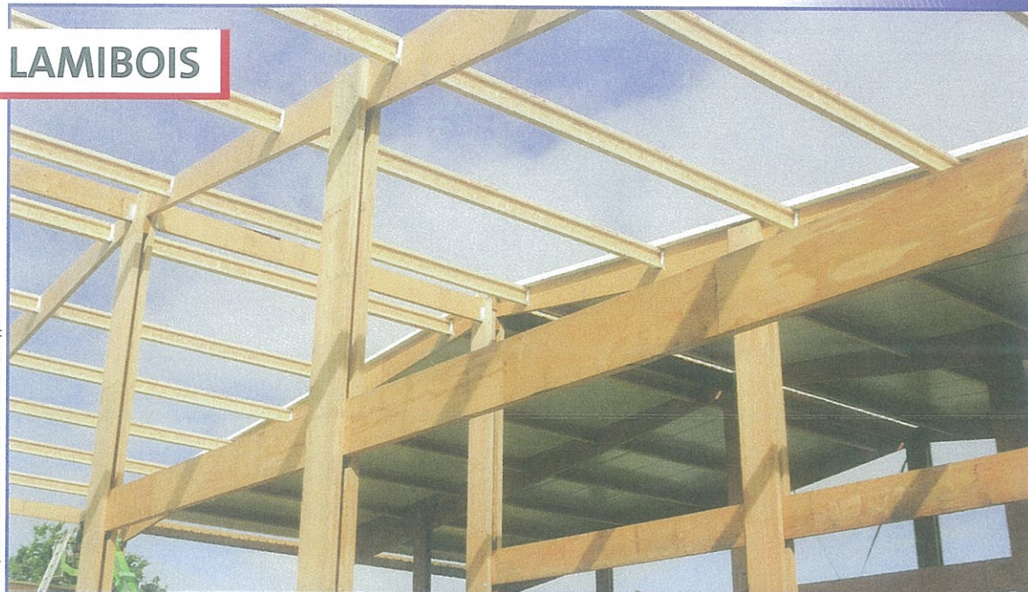
Lamibois type S (plis parallèles)
