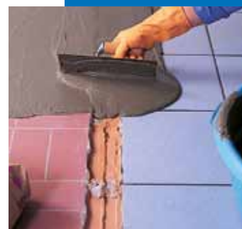
Ragréage localisé sur ancien carrelage avec Kerafluid F
