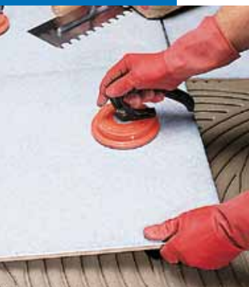
Pose de carreaux de grands formats
