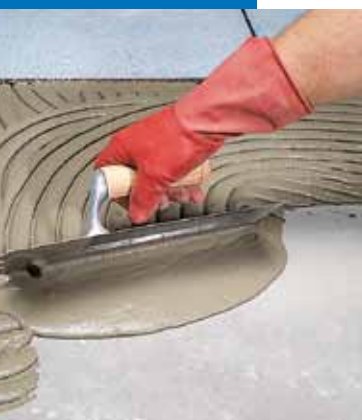
Application avec une spatule crantée
