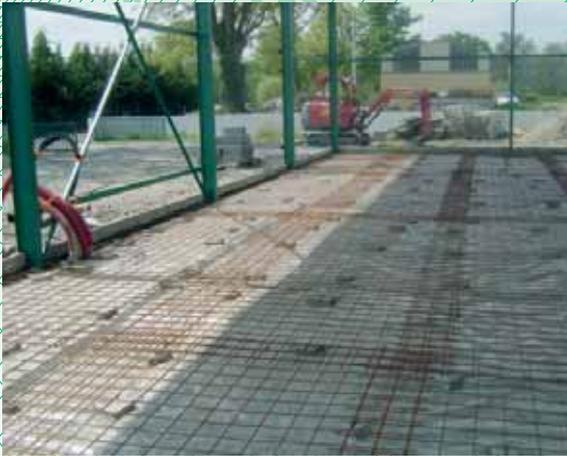
Compactage du hérission et pose des treillis soudés.
