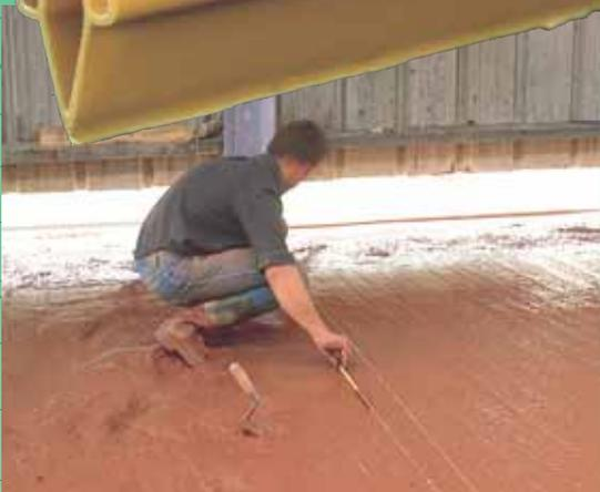
Il s'agit également d'un joint de fractionnement que l'on vient planter dans le béton frais.
