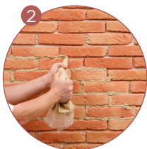
Je réalise les joints
