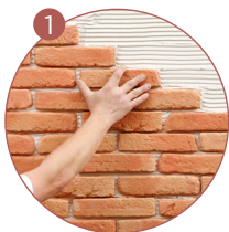
Je pose en croisant les joints d'une rangée sur l'autre
