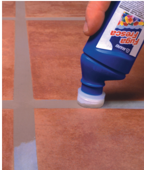
Traitement de joints de sol en terre cuite avec Fuga Fresca.
