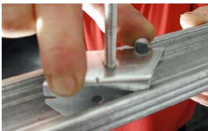
1. Après avoir vissé la tige fileté dans le cavalier, faites le pivoter dans la fourrure jusqu'au clic en vous aidant des languettes.
