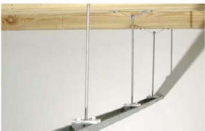
3. Exemple de montage d'un cavalier pivot sur support bois.
