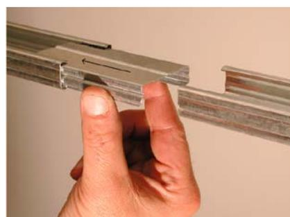
**2.** Enclencher le raccord dans la fourrure jusqu'au blocage de l'ergot.
