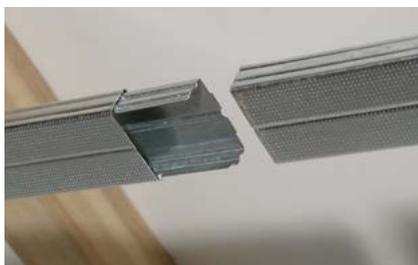
**1.** Disposer le raccord dans le sens inverse de l'ouverture des fourrures.
