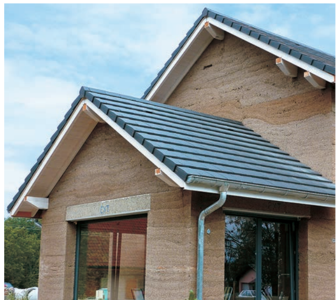
MAISON EN BÉTON DE CHANVRE Arbusigny (Haute-Savoie)
