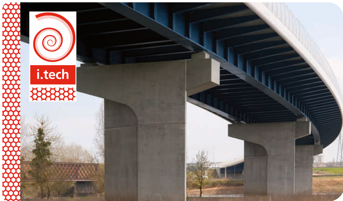
Viaduc de la Maine (49) - Architectes : Thomas Lavigne et Christophe Cheron.
