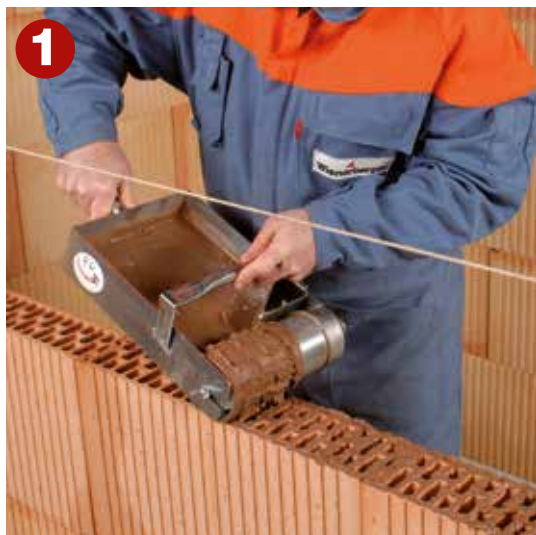
1 Appliquer le mortier pour joints minces à l'aide d'un rouleau équipé d'une pige de réduction.
