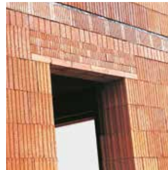
Linteau avec prélinteau et briques de compensation.
