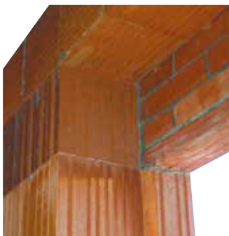
Lintheau pour volet roulant monobloc avec brique Feuillure 12.
