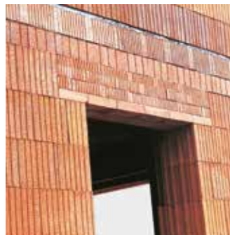
Lintheau avec prélintheau et briques de compensation.
