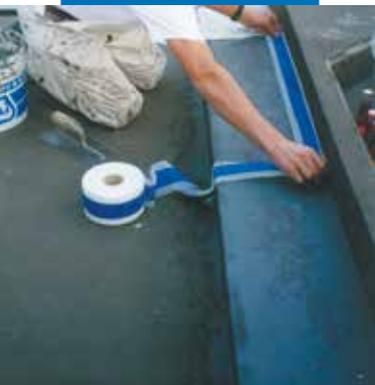
Imperméabilisation de la jonction entre le support et le bassin avec Mapeband.
