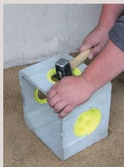
Avec un marteau pour diamètres 100, 110 et 125 mm
