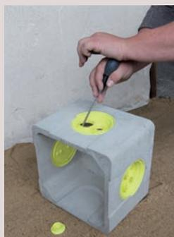
Avec un tournevis pour diamètres 28 et 45 mm
