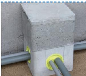
Mettre en place la rehausse et le couvercle. Remblayer.
