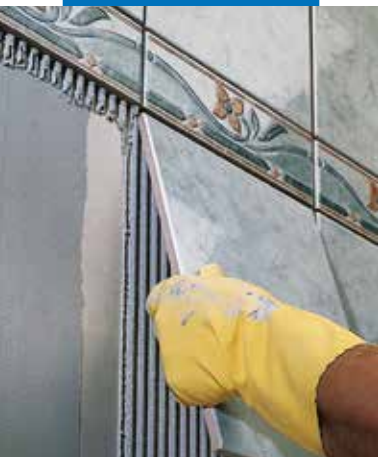
Pose de grès cérame en mur sur plaque de plâtre cartonné
