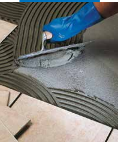
Pose de grès cérame en sol
