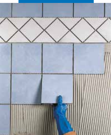
Pose de grès cérame en mur, sur enduit de ciment dans une salle de bains
