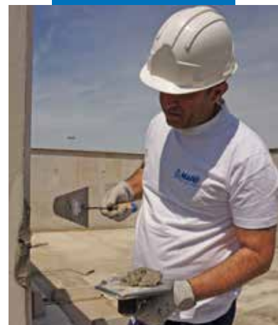
Application du mortier par couches successives selon l'épaisseur à réparer
