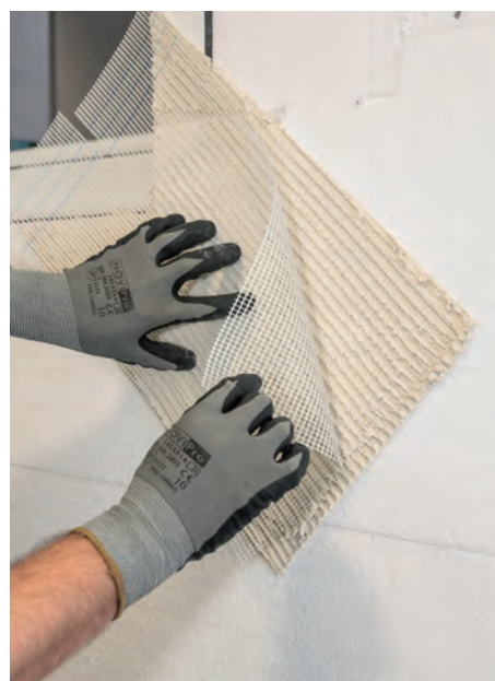
Réalisation d'un renfort d'angle en partie courante.
