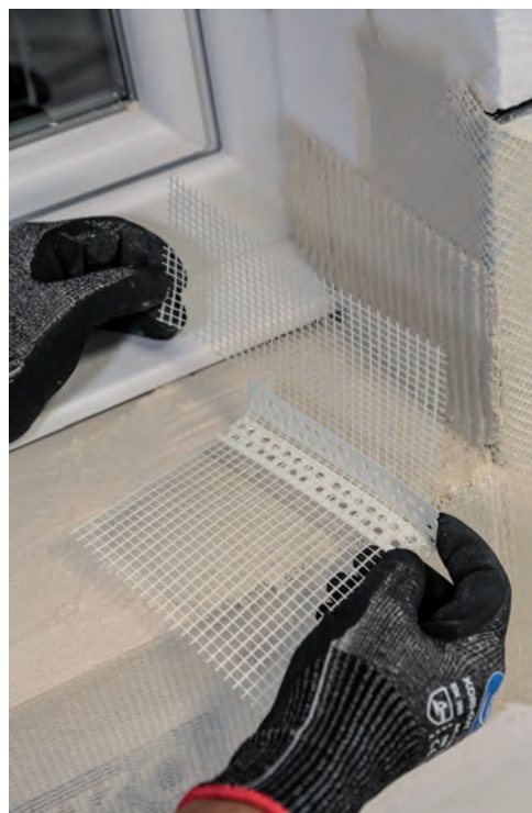
Réalisation d'un renfort appui-tableau.
