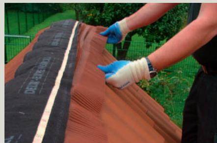
1. La pose est réalisée à froid en déroulant et centrant le closoir DELTA®-EXXTENSO ROLL sur le faitage ou l'arêtier puis en le fixant mécaniquement à l'aide d'agrafes ou de pointes sur la lisse de rehausse.
