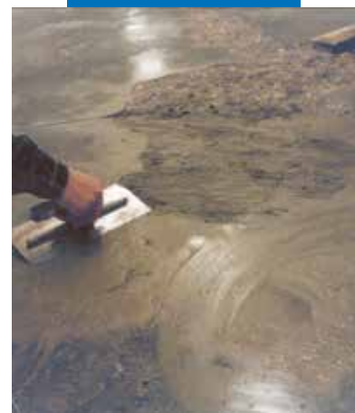
Réparation d'un sol industriel
