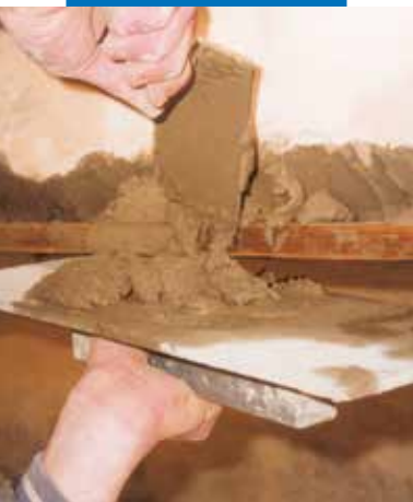
Réparation d'une allège de balcon : application du mortier
