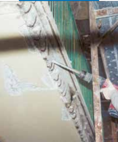
Réparation d'une allège de balcon: préparation du support
