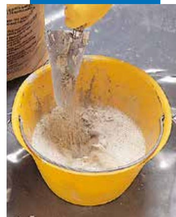
Préparation de la barbotine d'accrochage composée de Topcem et de Planicrete Latex
