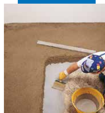
Application de la barbotine d'accrochage pour chape adhérente Topcem
