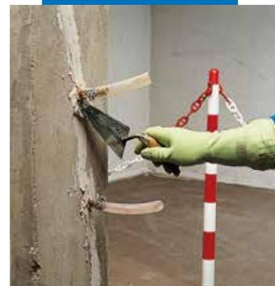
Fixation des injections avec Adesilex PG1
