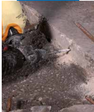
Préparation des trous pour l'insertion des armatures
