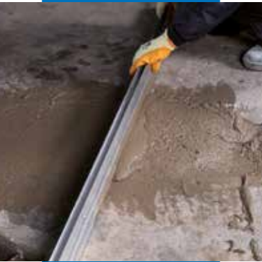
Réglage de Mapegrout SV Fiber
