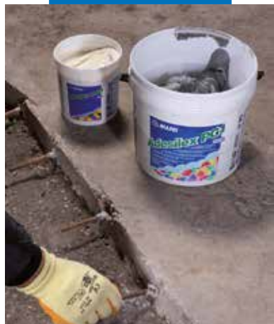
Fixation des armatures avec Adesilex PG1
