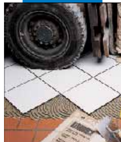
Rénovation rapide pour sol industriel
