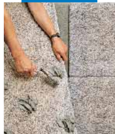
Pose de panneaux isolants lourds
