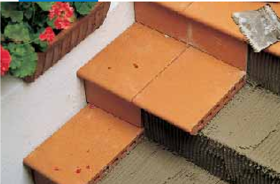
Rénovation rapide d'escalier
