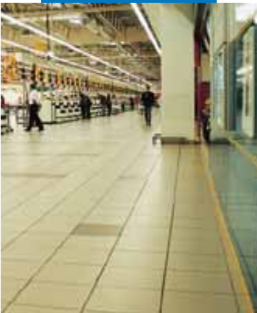
Pose de carrelage dans un supermarché Auchan avec Keraquick - Sosnowiec (Pologne)
