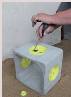
Avec un tournevis pour diamètres 28 et 45 mm
