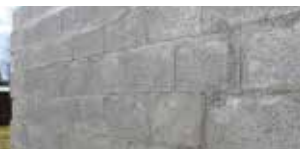
Maçonnerie de murs
