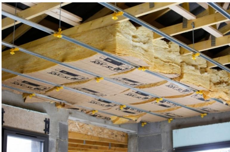
Le cavalier intégra2 est constitué de : › un embout à raccorder sur une tige filetée de diamètre 6 mm › une coupelle permettant le maintien de l'isolant › une clé qui garantit la continuité de l'étanchéité à l'air et permet de fixer l'ossature métallique
