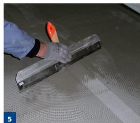
5 Recouvrement des lés sur une largeur de 5 cm minimum.
