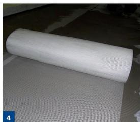
4 Préparer et dérouler la **TRAME LANKOPHONIC** sur le lit du mortier-collé.
