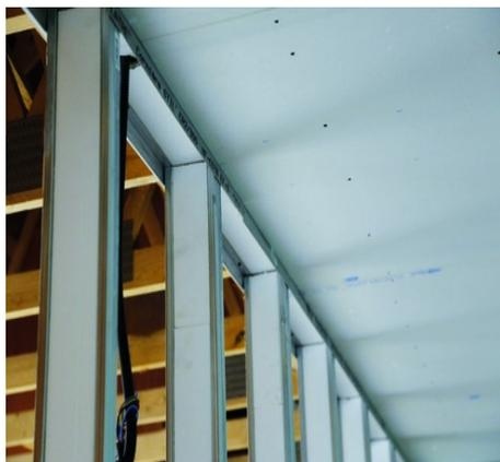
Montant isolant Up Stil® pour réaliser des cloisons séparatives Up Stil®
