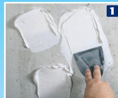
**1** Déposer de petites quantités d'enduit côte à côte à l'aide d'une spatule, sur une surface d'environ 1 m<sup>2</sup>, en commençant par le bas.
