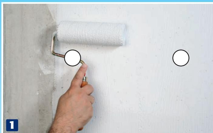
**1** Appliquer l'enduit à l'aide d'un rouleau de manière homogène sur une zone de 1 m<sup>2</sup> environ.
