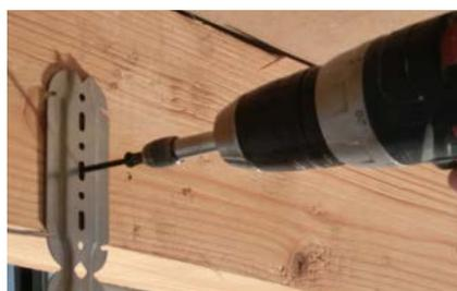
**2.** Après repérage du niveau, prépositionner directement les suspentes dans les trous oblongs. Les fixer définitivement, avec des vis adaptées au support dans les trous ronds.
