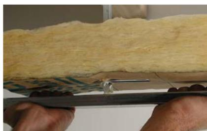
**3.** Embrocher la laine. Clipser les fourrures sur les suspentes en engageant une aile dans la fente horizontale et pivoter vers vous jusqu'au clic.
